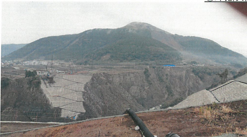
①. 阿蘇大橋(大規模斜面崩壊／国)
