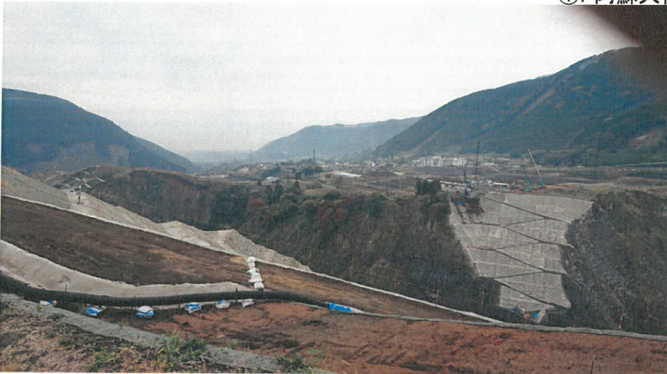
①. 阿蘇大橋(大規模斜面崩壊／国)
