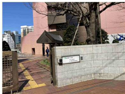
↑北部下水道事務所（台東区）
