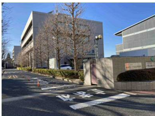
↑西部第一下水道事務所（中野区）
