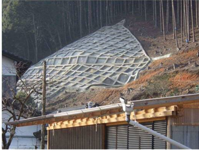
写真 初めて担当した法面工事（喜多良地区）
