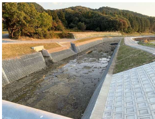
写真 1. 初めて担当した護岸工事（荷原川）
