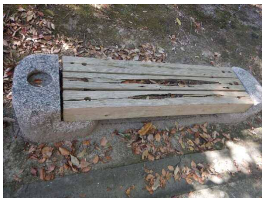
劣化した木製の座面
